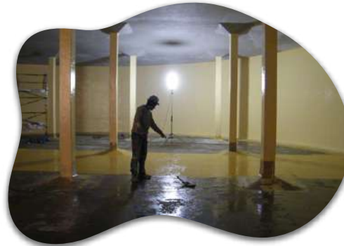
Revêtement surface dans un château d'eau
