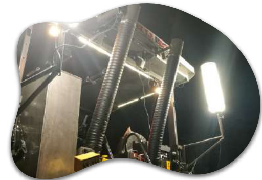
Travaux de route, installation sur Finisher
