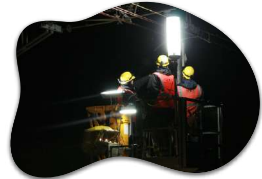
Construction : travaux sur voies ferrés
